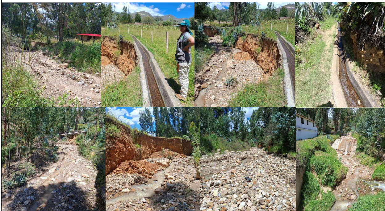
Imágen N°01.- Se observa en las fotografías, que la quebrada ANDADEN, se encuentra colmatado en su cauce y socavado en sus ambas márgenes, ubicadas en el sector: LA HUARACLLA
